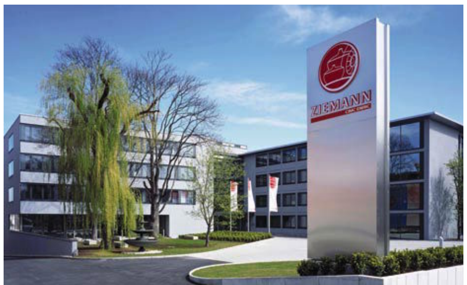
Der Ziemann-Standort in Ludwigsburg wurde von der holländischen Firma Holvrieka übernommen.
