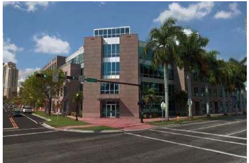
Die neue Niederlassung von coresystems in Miami.
